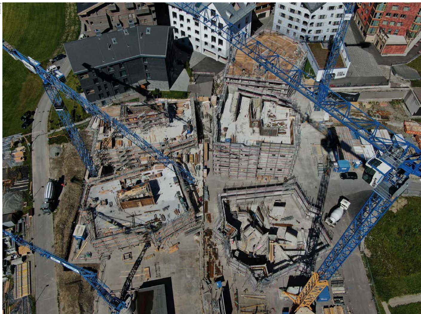
Auftragsverlagerung weg vom industriell-gewerblichen Bau im Jahr 2021 erwartet
