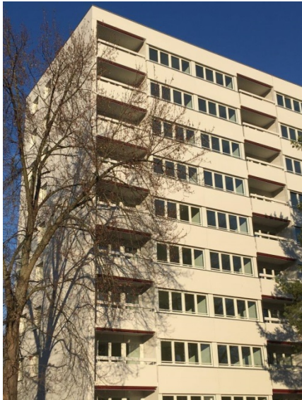
Abbildung 6 – Bei der Gesamtanierung Überlandstrasse Zürich wurden die Lean-Prinzipien angewendet (Foto: Implenia)
