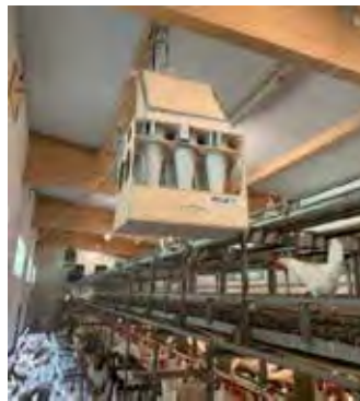
Abbildung 5: Multizyklonfilter im Legehennenstall
