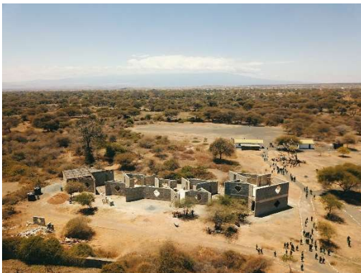
Abb. 1: Bauphase des neuen Schulgebäudes (APC Tanzania, 2020)
