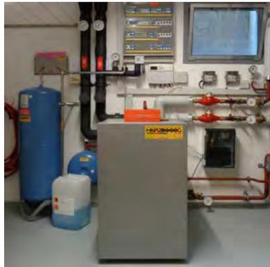
Abbildung 2 Wärmepumpe in Heizzentrale
