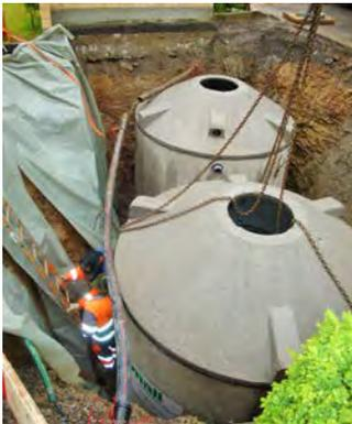
Abbildung 1 Einbau Eisspeicher
