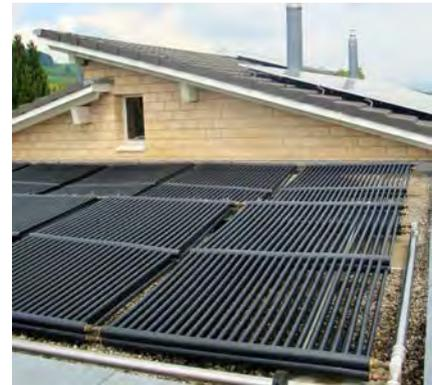
Abbildung 3 Absorber-Anlage auf Dach
