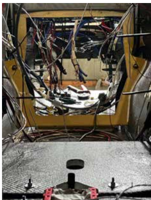
Abb. 3: Installation Kabelbaum aus Sicht von hinten nach vorne
