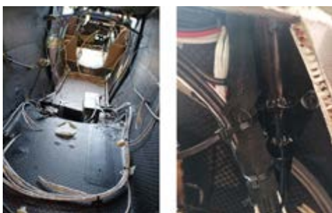
Abb. 3 Montage des Kabelbaumes
