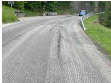
Abb. 2: Schäden in der Tragschicht
