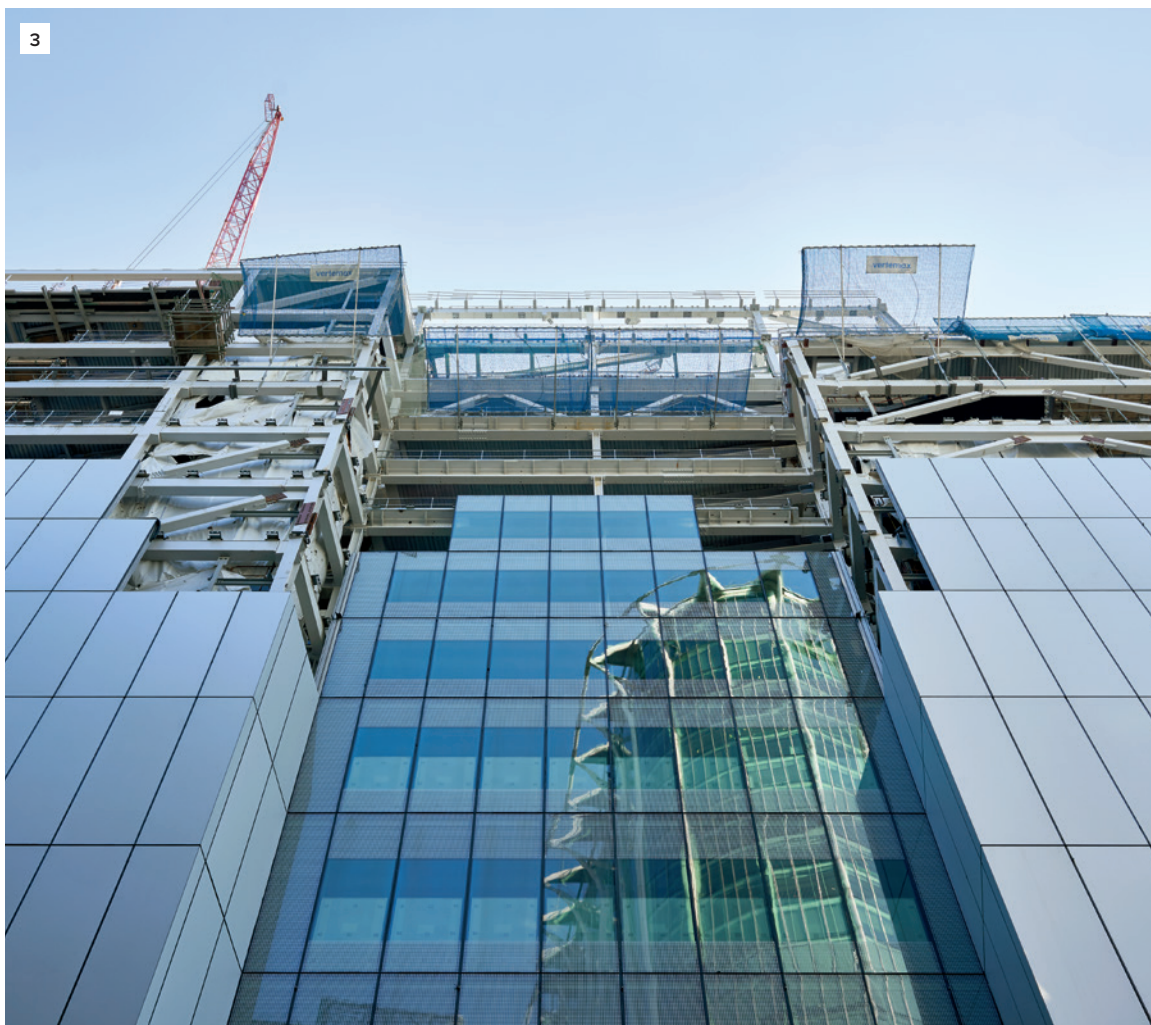
2 Montage der Fassadenelemente auf der Baustelle 21 Moorfields mit dem Turmdrehkran. Die Elemente übernehmen den architektonischen Ausdruck der Stahlstruktur, Josef Gartner GmbH
