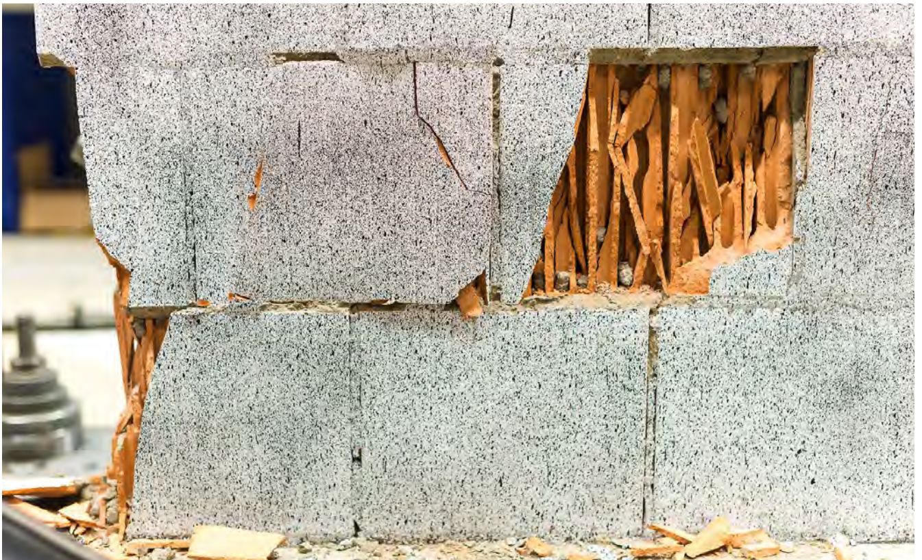
Vom kleinsten Riss bis zur zerstörten Fassade: Die Auswirkung von Erschütterungen auf Baumaterialien wird akribisch dokumentiert.
