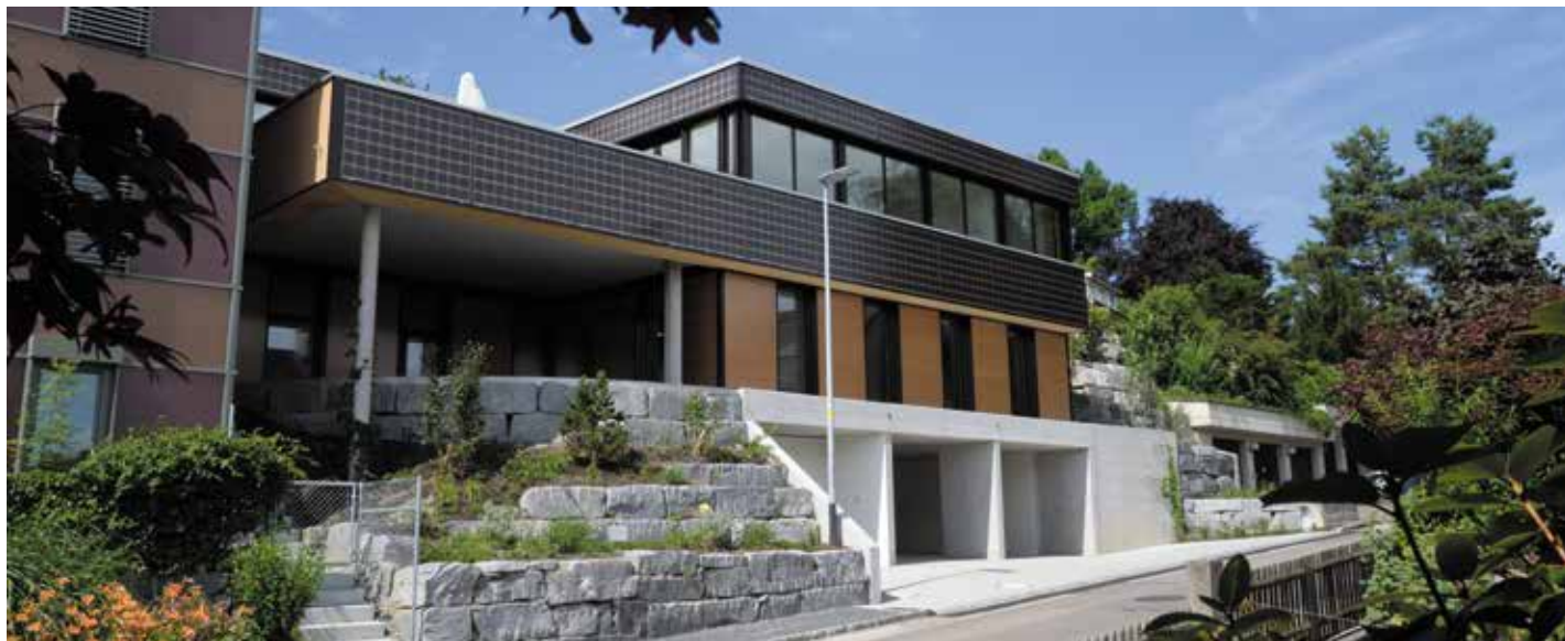
An diesem Wohnhaus in Wil SG wurde eine Photovoltaikanlage installiert (Bild: Fent Solare Architektur).
