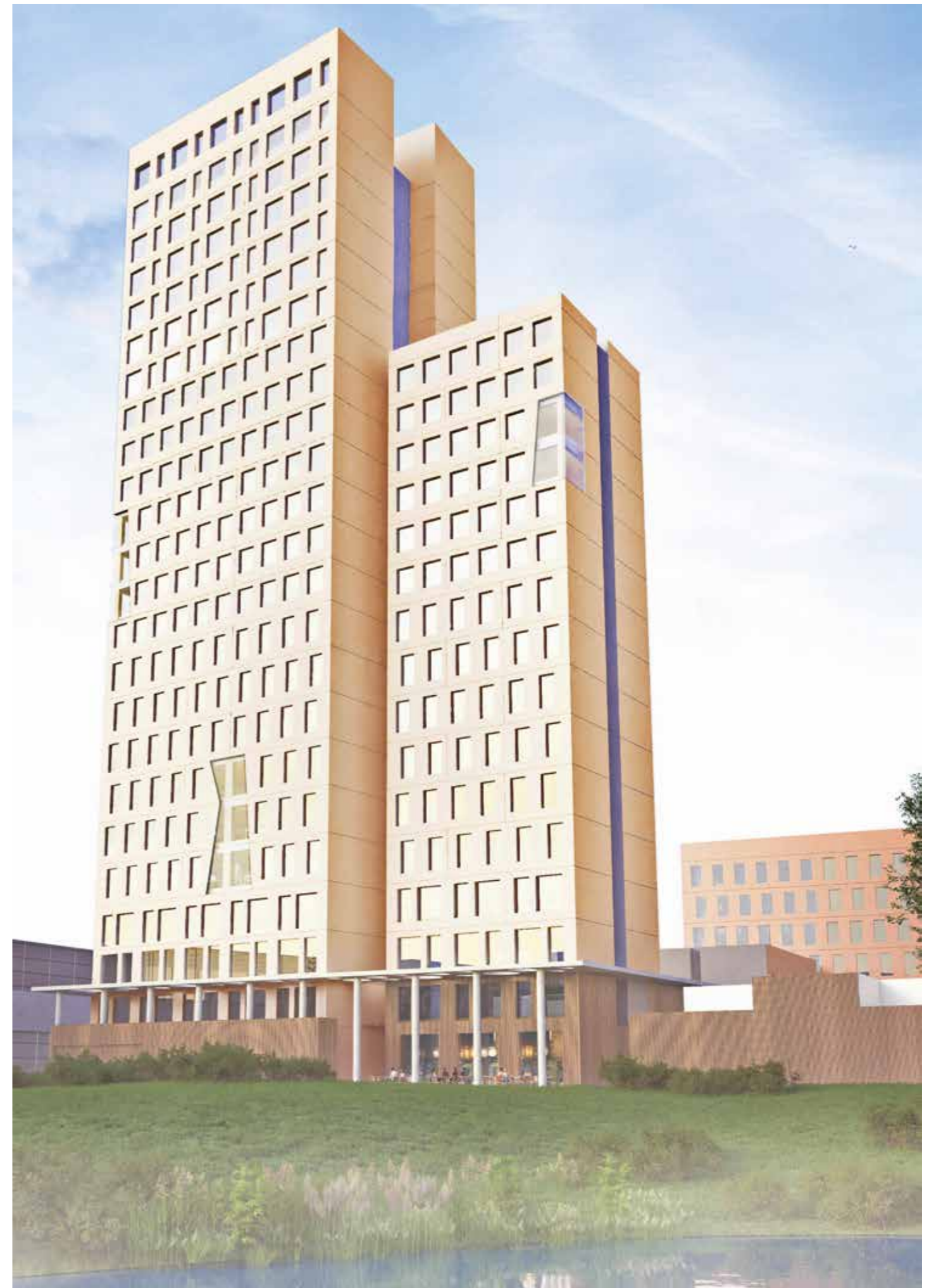
Mit 84 Metern Höhe und 24 Stockwerken ist das entstehende Hochhaus in der Wiener Seestadt Aspern bald das höchste Holzhaus der Welt.
