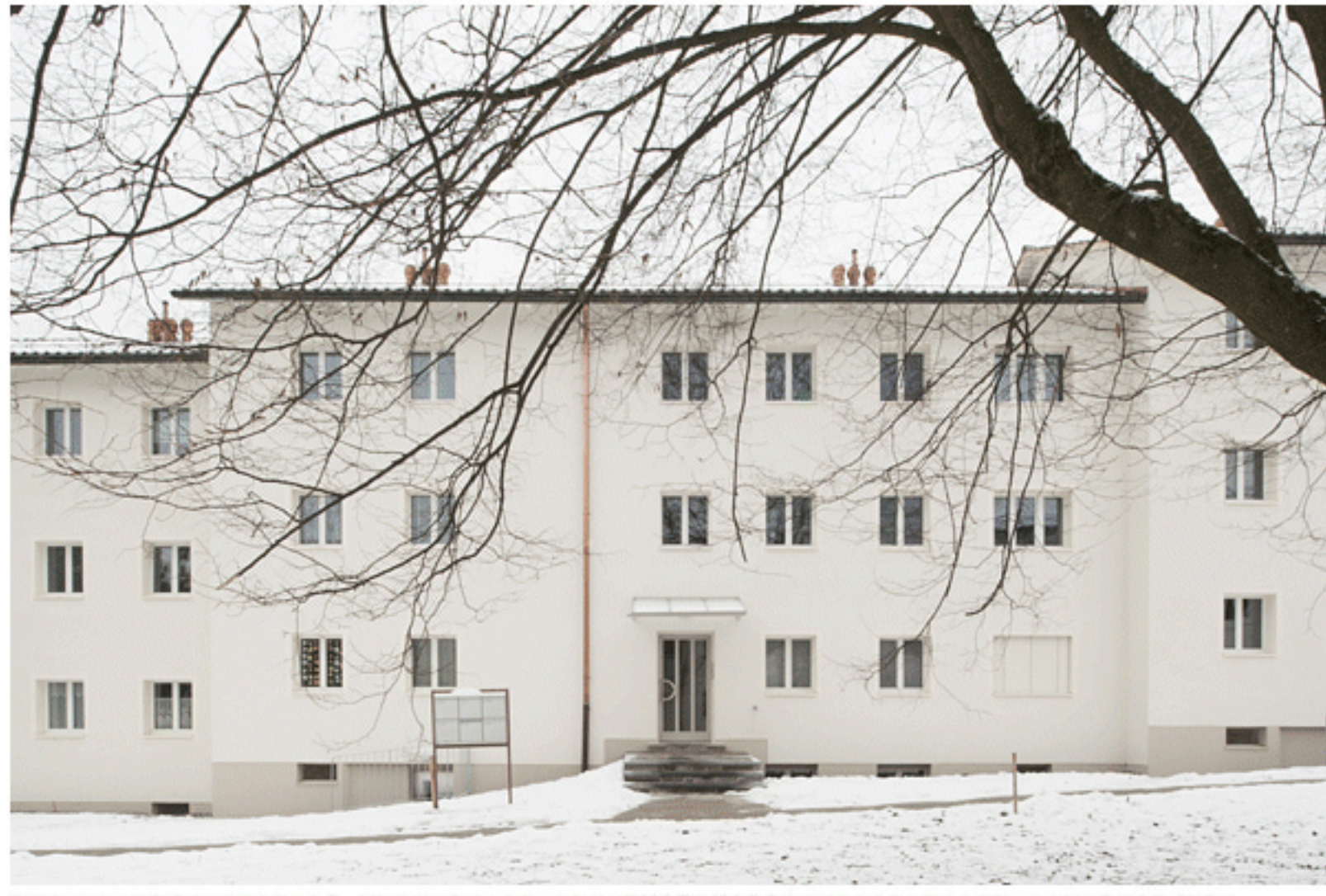
Siedlung Eyhof, erhaltener Teil, der von Streuli & Partner Architekten totalsaniert wurde. Bild: Baugenossenschaft Schönheim.
