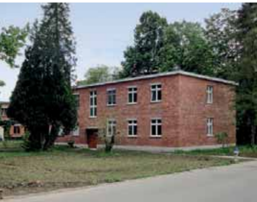
Das sanierte Ledigenhaus: Aussen kaum verändert, finden sich im Innern anstelle zahlloser kleiner Räume zwei Wohnungen mit integrierten Ateliers.
