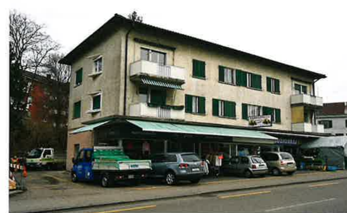
Mit einer Aufstockung entstehen zusätzliche Wohneinheiten.
