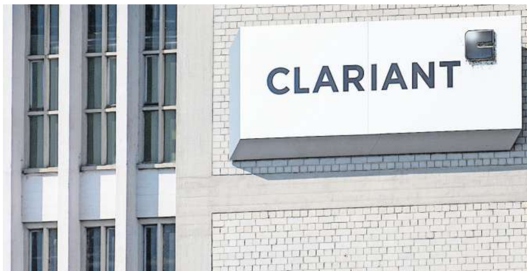
Das Clariant-Chemiewerk in Muttenz.
