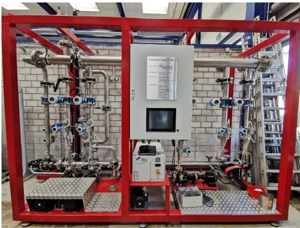
Abb. 1: Pumpenprüfstand im Labor
