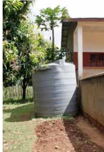
In diesem 10'000 Liter Fass soll künftig das Quellwasser in der Schule zur Verfügung stehen
