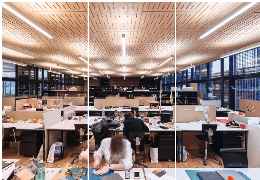
Variation der Farbtemperatur zwischen 3000 K und 6000 K. Die Beleuchtungslösung für Ausbildung und Forschung entstand 2017 in Kooperation mit der Moos Licht AG (Leuchten) und der Tridonic AG (LED und Steuerung).
