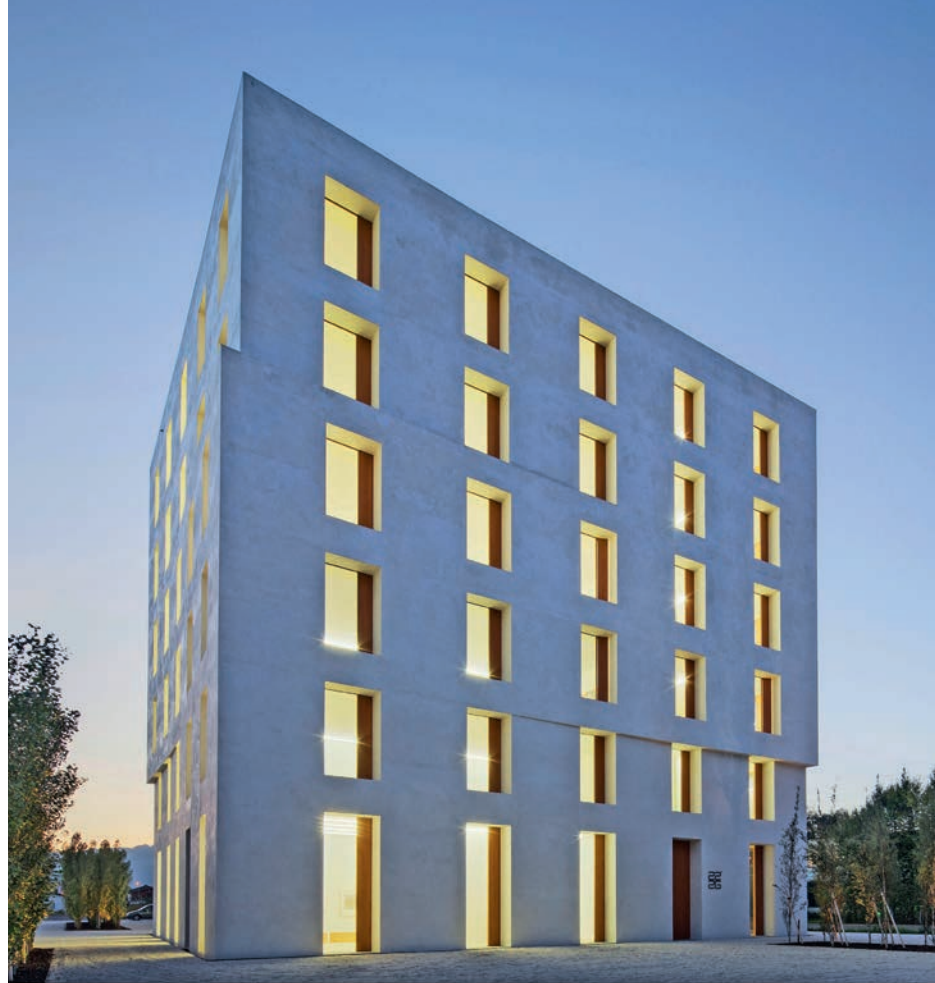
Der Experimentalbau «2226» des Architekturbüros Baumschlager Eberle im vorarlbergischen Lustenau kommt gänzlich ohne Heizungs-, Lüftungs- und Kühlungsanlagen aus. Einzige Heizquelle ist die Wärmeabstrahlung von Gebäudenutzern und elektrischen Geräten.
