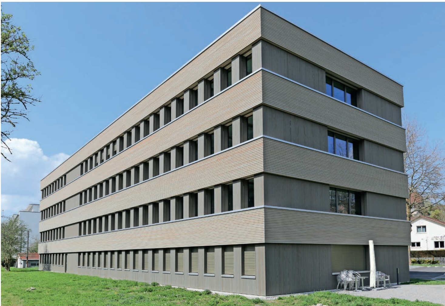
Das von Mischa Badertscher Architekten entworfene Verwaltungsgebäude des Bundesamts für Raumentwicklung ARE in Ittigen bei Bern wurde 2013 fertiggestellt. Es ist nach Minergie-P-Eco zertifiziert, 2000-Watt-kompatibel und erfüllt die Anforderungen nach Gesundem Innenraumklima (GI).
