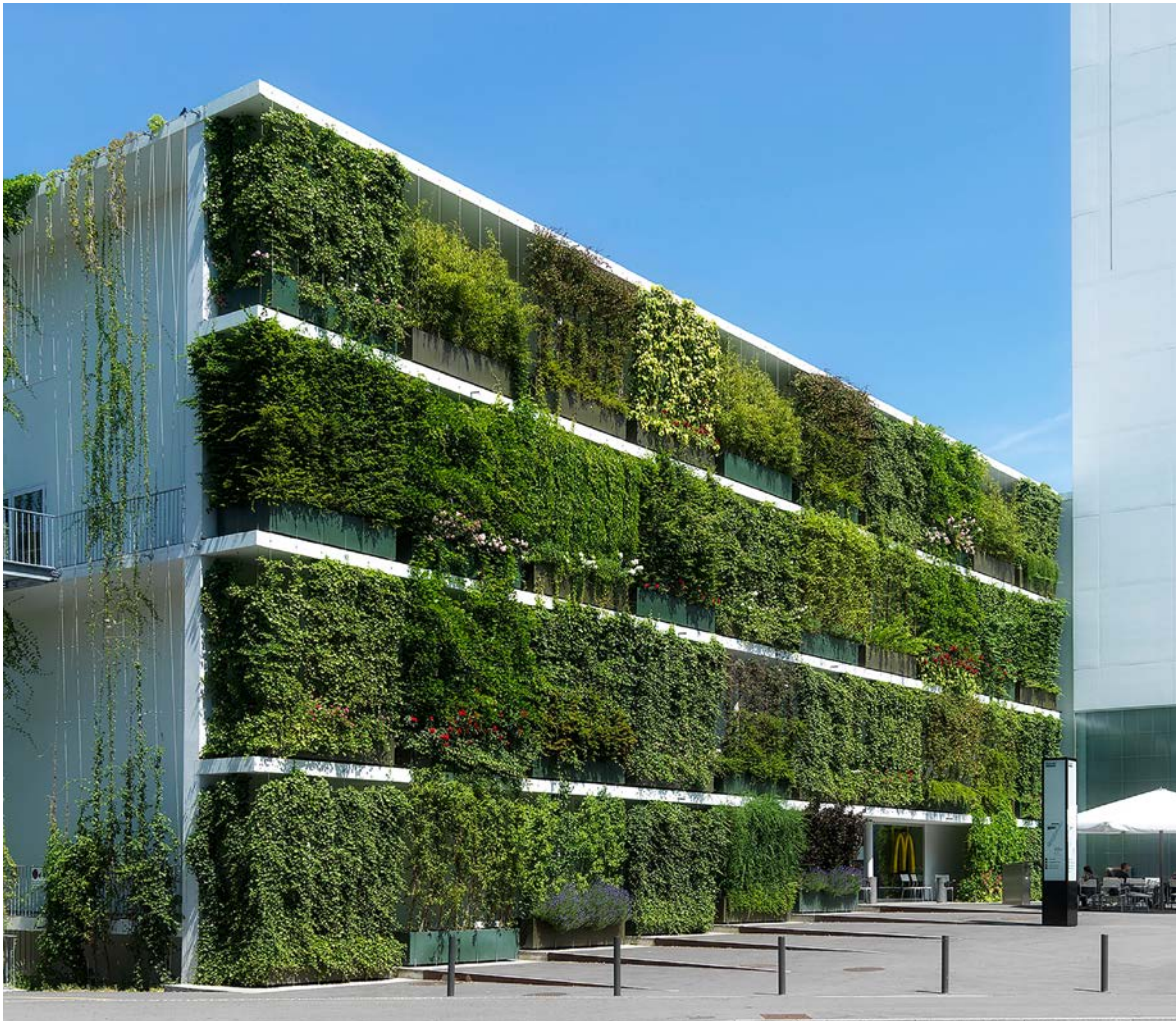
Abb. 2: Beispiel einer «wandgebundenen» Begrünung: Stüchi-Einkaufszentrum in Basel. Die Begrünung besteht aus 23 verschiedenen Gehölzarten und Kletterpflanzen. Die Pflanzen befinden sich in Trögen und ranken sich an Seilen empor.
