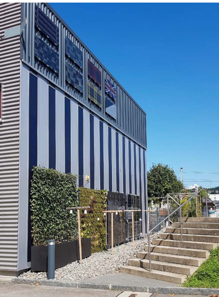
Abb. 4: Auf dem HSLU-Campus wurden vier Fassadensysteme ausgemessen (von links nach rechts): bodengebundene Begrünung, wandgebundene Begrünung, opake PV-Anlage, transparente PV-Anlage.
