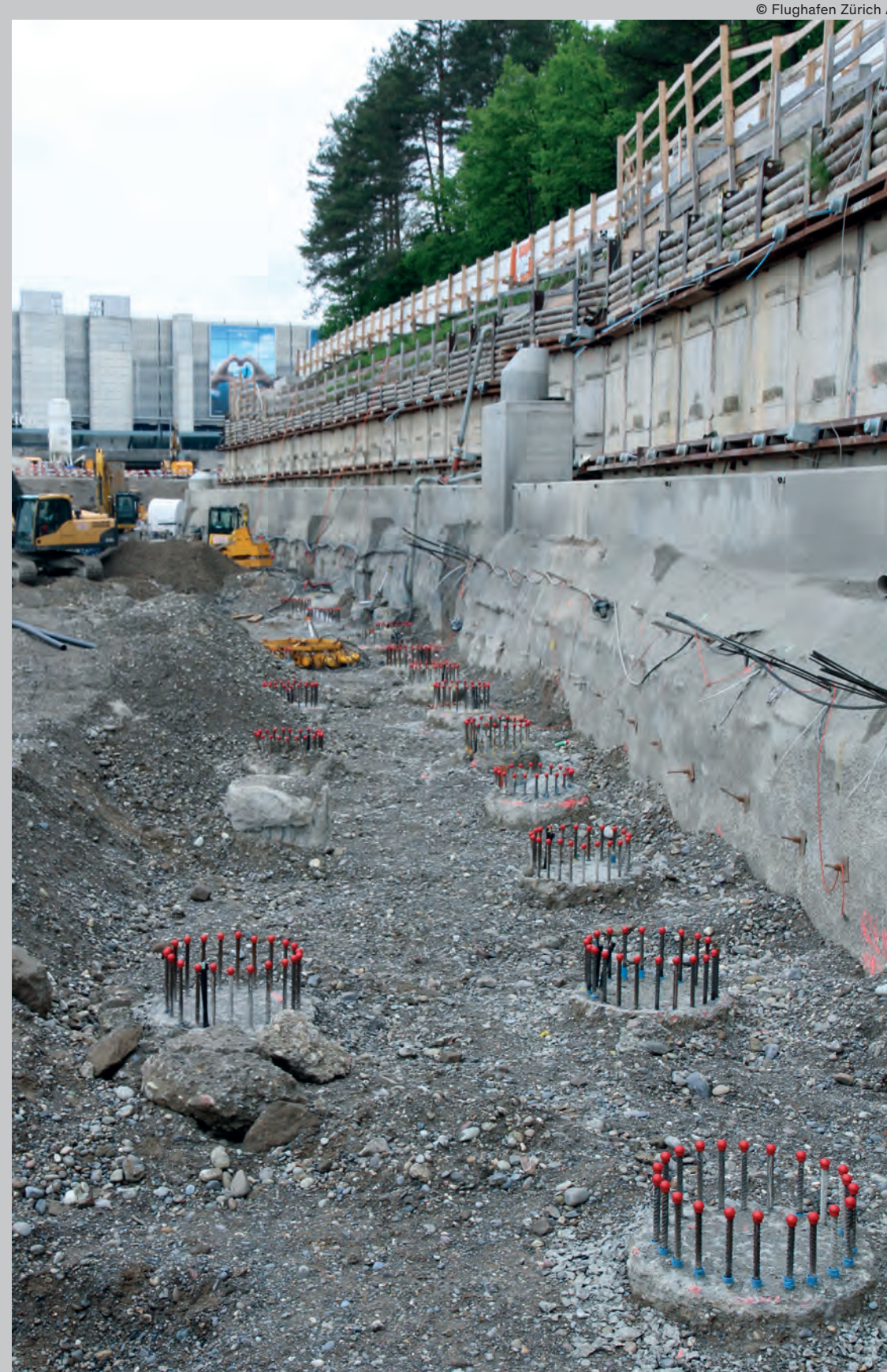
Bau der Energiepfähle
