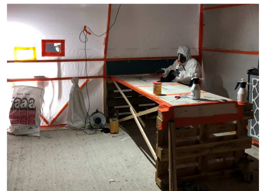
Schadstoffsanierung der Fassadenbleche auf der Baustelle
