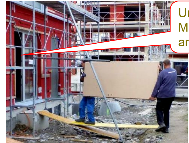
Temporäre geteerte Rampe mit grosser Ausparung im Gerüst
