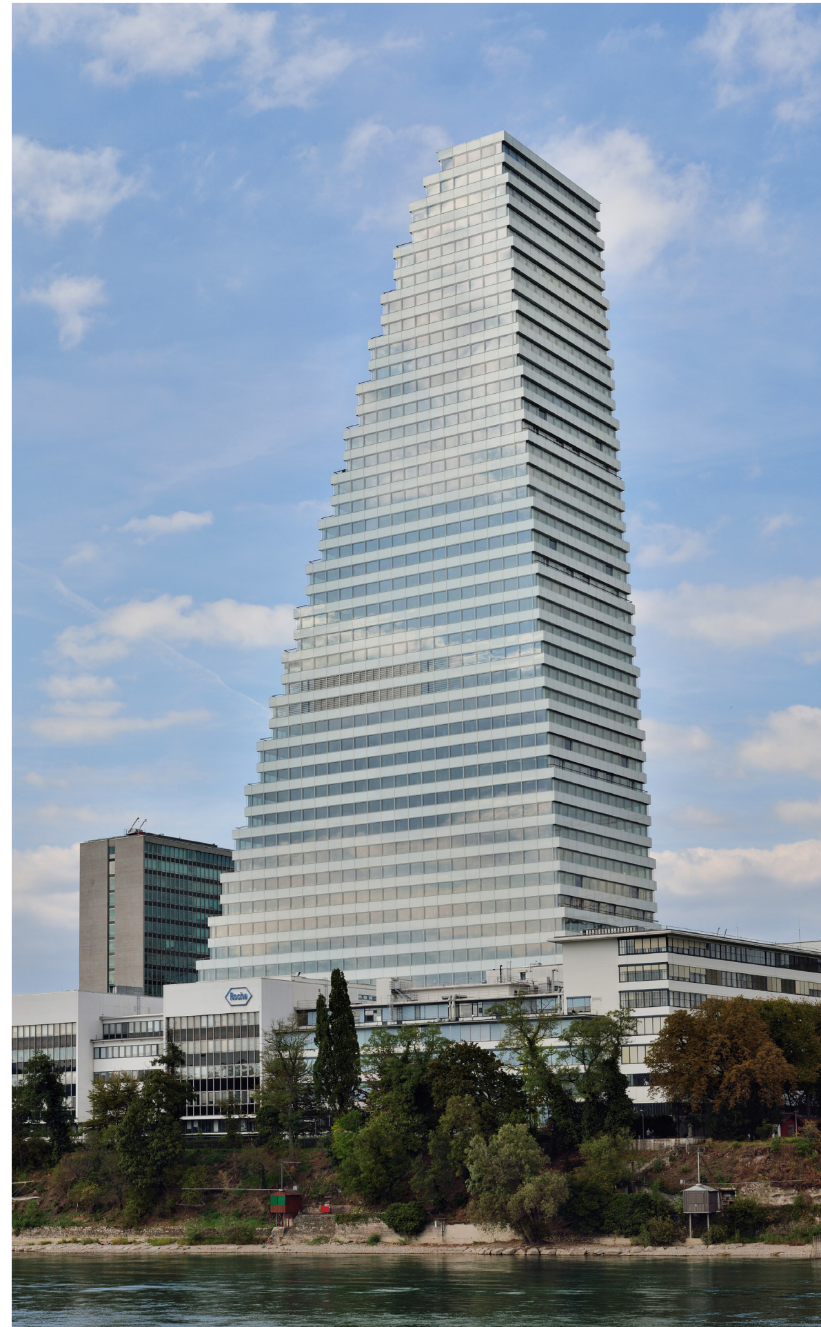
Abbildung 1: Hochhaus, Basel, September 2015 [6]
