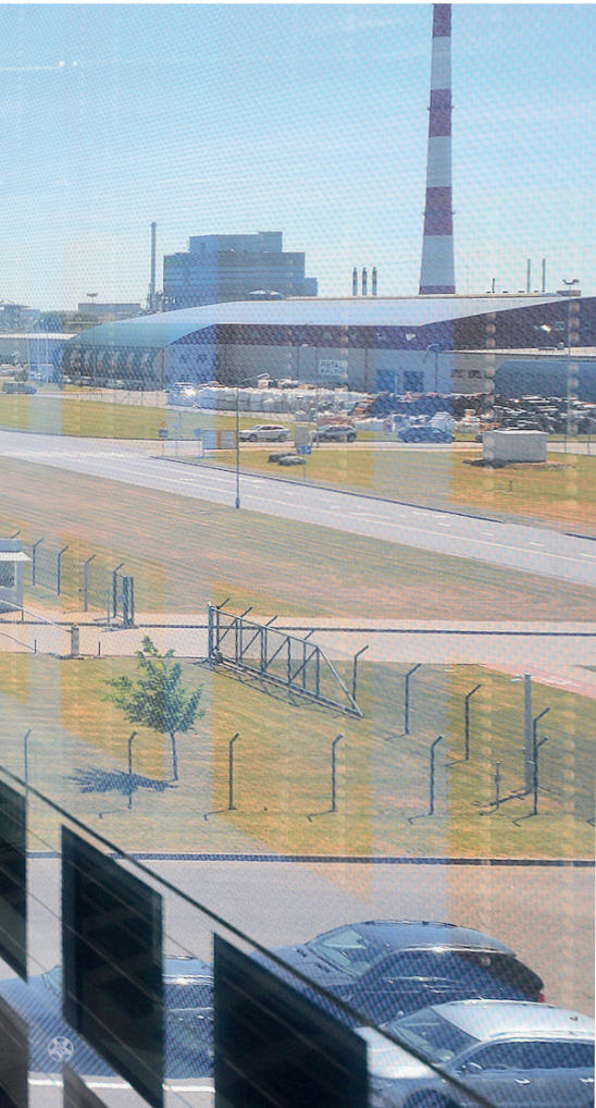
Double-skin-Fassade mit kristalliner Solarzelle in Klaipėda (Litauen). Die Glasmodule schützen das Gebäude vor Überhitzung und Windlast.
