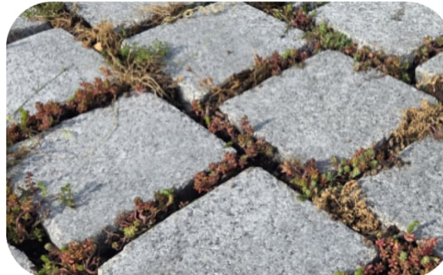
Granit, Reihenpflasterung Splittfuge 30mm, mit Begrünung
