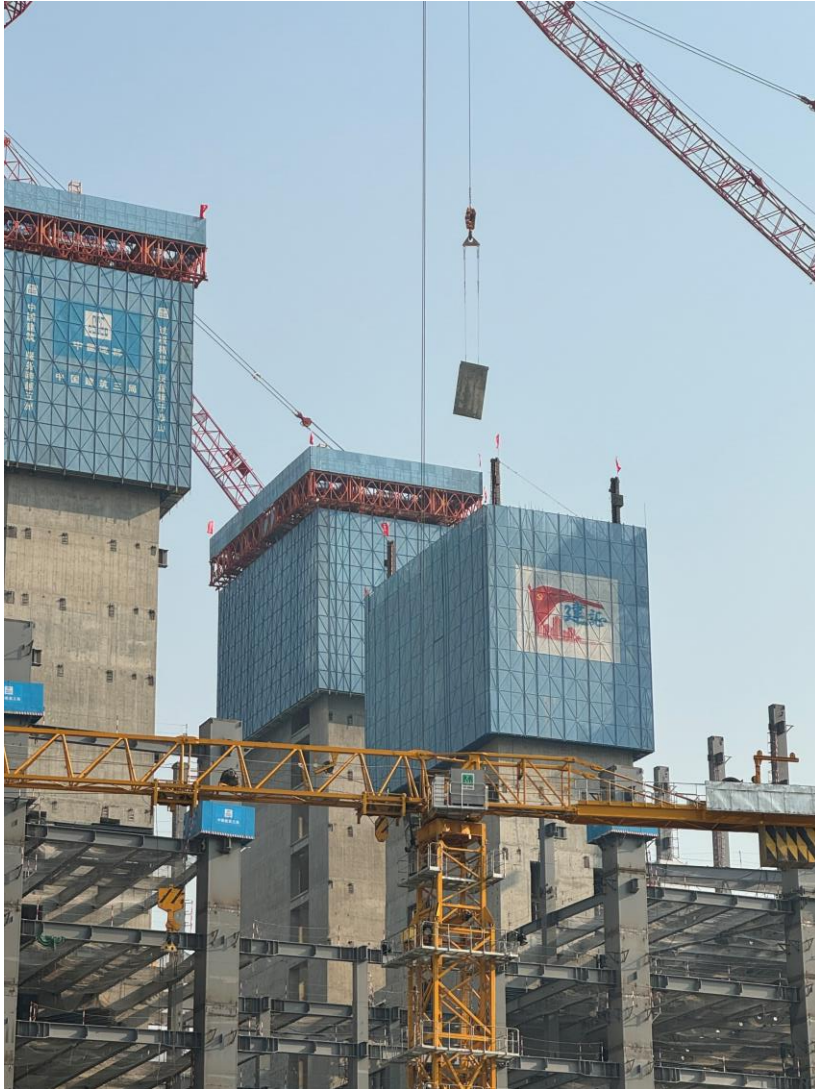
Copyright : Sino-Swiss ZEB Project, eine Baustelle von Beijing CBD
