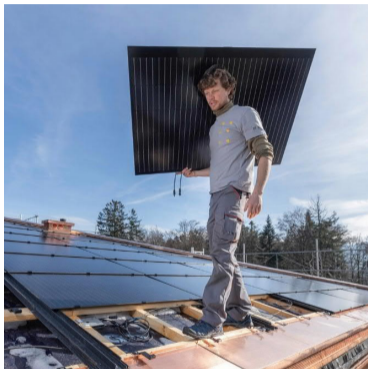
Montage dachintegrierte 15 kWp-PV-Anlage in Horw (BE Netz) Bildquelle Monteure: © Swissolar
