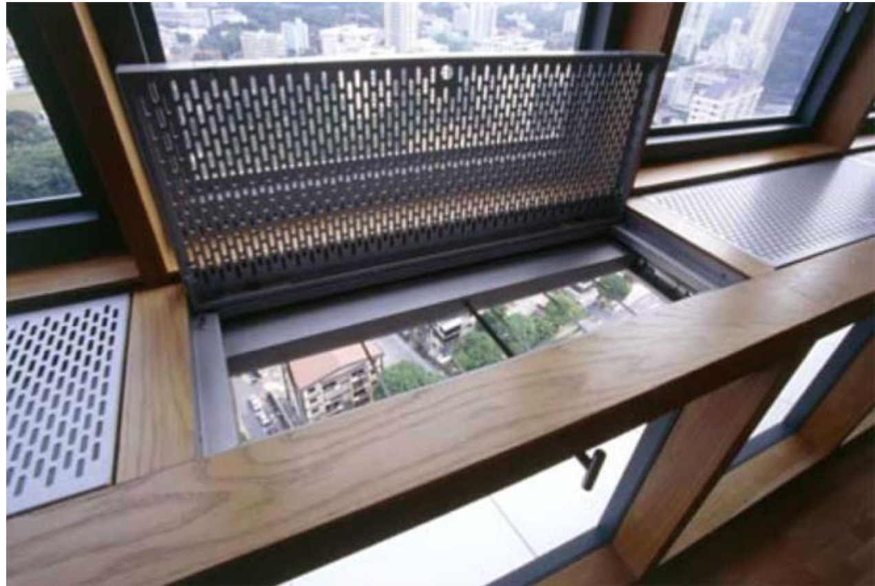
Lüftungsklappe Moulmein Wohnhochhaus in Singapur, WOHA Architects, 1999
