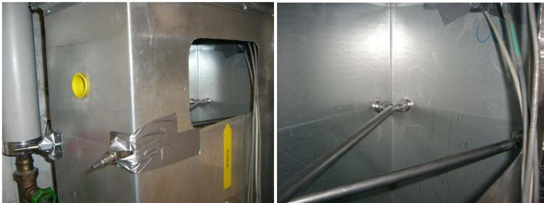
Abbildung 14: Platzierung des Messkreuzes im Fortluftkanal (Links), Details zur Befestigung des Messkreuzes im Kanal (Rechts)
