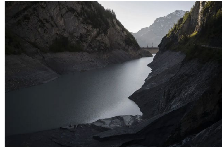
Dank den Speicherseen in den Bergen, im Bild die Stauanlage Gigerwald (SG), ist die Schweizer Energieversorgung vergleichsweise resilient.
