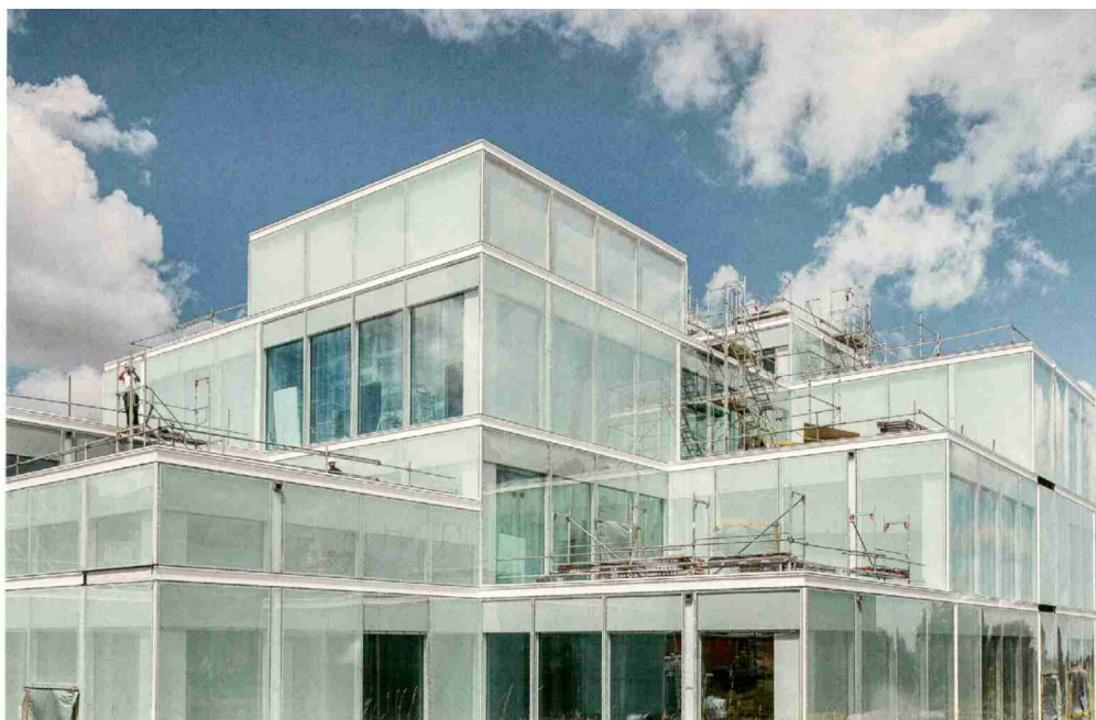
2 Neubau Square der Universität St.Gallen, Architektur Sou Fujimoto: Die 448 Fassadenelemente (geschlossene Doppelhauffassade mit innen liegenden Rafflamellenstores) sind direkt miteinander verbunden, wurden vorproduziert und liessen aufgrund der brüstungslosen Montage keine Toleranzen zu. Nouveau bâtiment Square de l'Université de Saint-Gall, architecture de Sou Fujimoto: les 448 éléments de façade (façade double peau fermée avec stores à lamelles intérieures) sont directement reliés entre eux, ont été préfabriqués et n'ont permis aucune tolérance en raison du montage sans allège. Nuovo edificio Square dell'Università di San Gallo, architettura di Sou Fujimoto: i 448 elementi dell'involucro (facciata chiusa a doppia pelle con lamelle a pacchetto interne) sono direttamente collegati tra loro, la prefabbricazione non ha consentito alcuna tolleranza a causa dell'assemblaggio senza parapetti. FOTO: HSG STIFTUNG | CHRIS MANSFIELD
