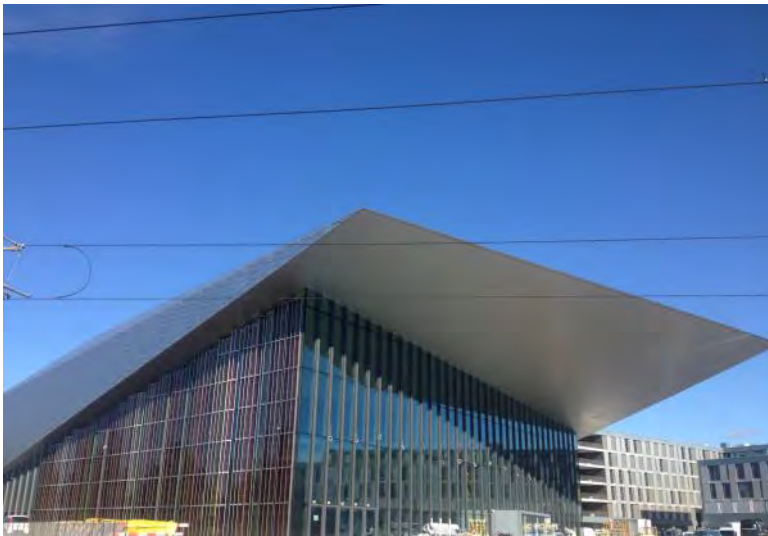
SwissTech Convention Center, EPFL Lausanne Fassade mit 300 m 2 farbigen PV Module südwest-orientiert, Design Daniel Schlaepfer and Catherine Bolle
