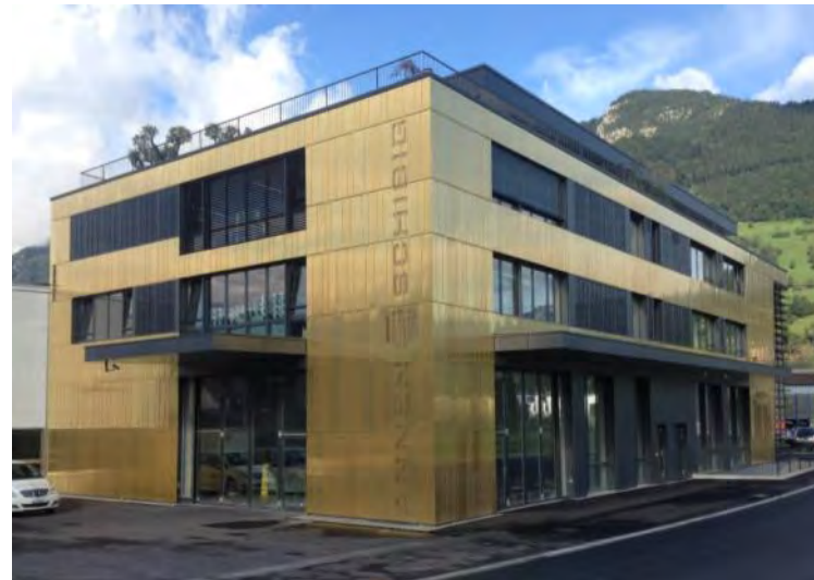
Annen + Schibig AG Ibach, Schwyz 70 m2 südorientierte hinterlüftete PV Fassade hinter Lochblech
