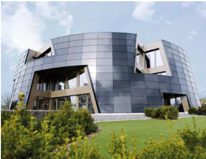
Hauptsitz Berger und Frank Architekten AG Sursee, Luzern 18 kWp südorientierte hinterlüftete PV Fassade Quelle: brighthouse AG
