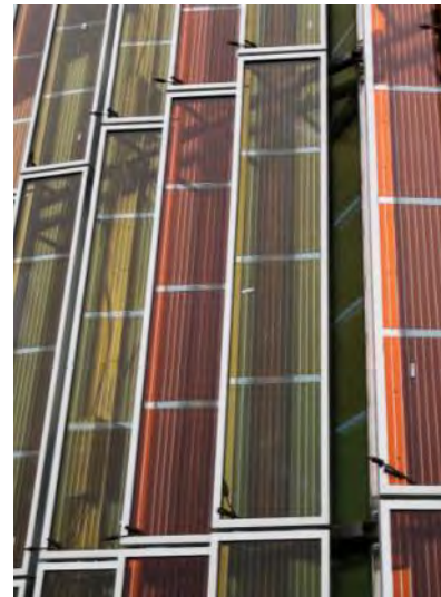
Farbige und transparente PV Module (Grätzel Zelle) in der Aussen- und Innenansicht (Quelle: Alain Herzog / EPFL)
