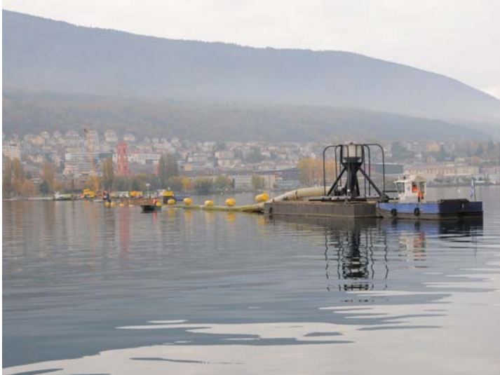
Erneuerbare Energien | Bauphase der unterirdischen Leitung für Seewasser zur ökologischen Gebäudekühlung (Foto Viteos)
