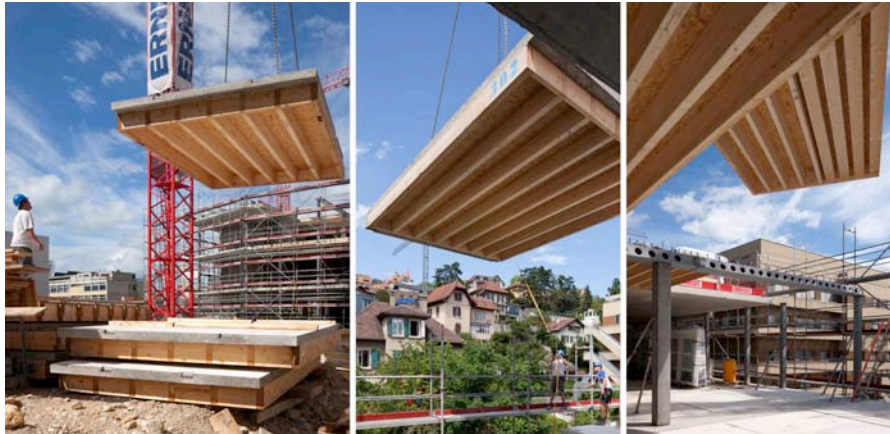
Einbau der hybriden Tragelemente aus Holz und Beton (Fotos Y. André)
