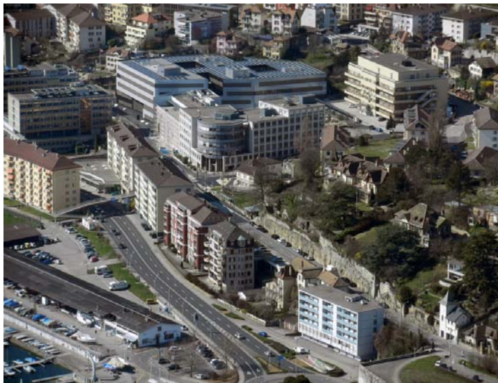
Erneuerbare Energien | Solardach mit Testplattform (Foto ERNE) | 1'271 m 2 | 224'500 kWh/Jahr (ca. 64 Haushalte)
