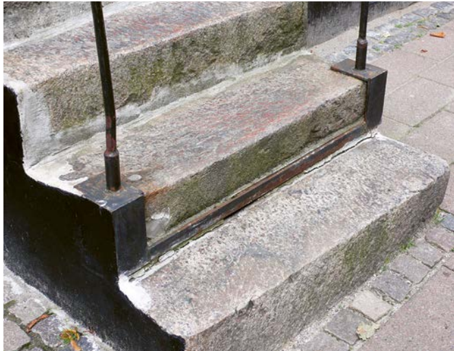
→ Abb. 2: Geländeranschluss Aussentreppe in Helsingør, Dänemark
