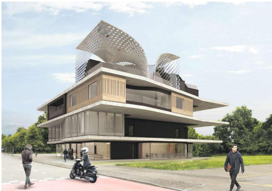
Das offene Stahlbetonskelett ist fix, Räume und Fassaden im «Nest» sollen dagegen austauschbar sein.
