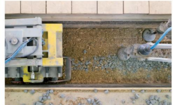
Eine Schicht aus dämmenden Schaumglasbrocken wird mit eingestampft.
