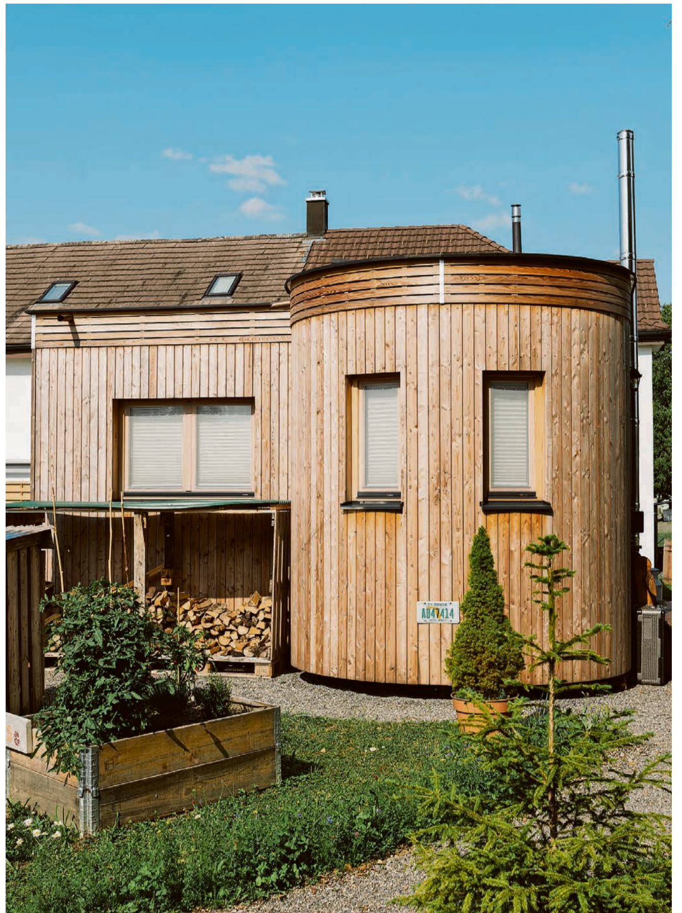
Das winzige Häuschen steht auf einer Parzelle, die die Mauchs gepachtet haben – zur Zwischennutzung.
