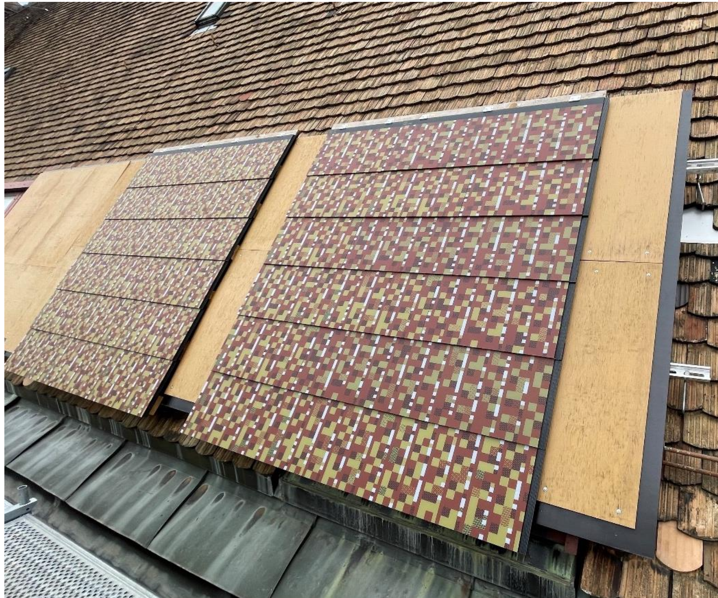
Entwürfe als Mockup mit funktionierenden PV-Modulen, Bilder: Plan-E AG
