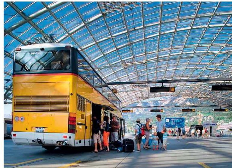
Busbahnhof Chur: Die Zusammenarbeit der verschiedenen Verkehrsträger ist in der Bündner Hauptstadt vorbildlich.
