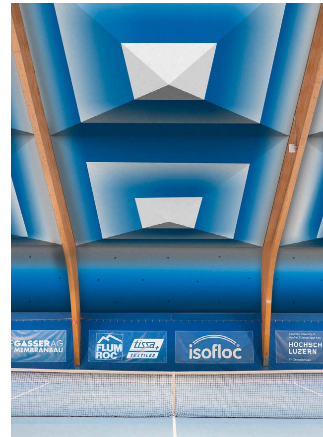
Tennisfans schwingen den Schläger künftig unter einem Textil-Himmel: Visualisierung einer textil sanierten Tennishalle mit den Dämmelementen «Baldachin» (l.) und «Schirm».
