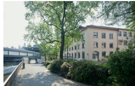
Die Sentimatt beherbergte einst die Schindler-Liffabrik.
