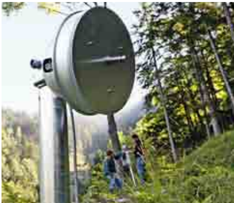
Zwischen zwei Sensoren liegen bis zu 20 Meter.
